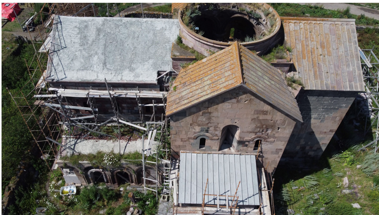
სურ. 5. კუმურდოს კათედრალზე მიმდინარე სარეაბილიტაციო-სარეკონსტრუქციო სამუშაოები (2023წ.) (ფოტო – ბ. გერსამია).
